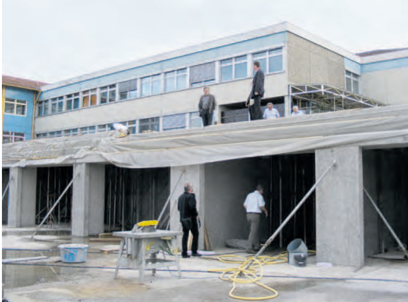
Tribüne oben, Geräteraum und Treppenaufgang unten. Immer deutlicher sind die verschiedenen Bauteile der neuen Sporthalle erkennbar. Fotos: Berger
